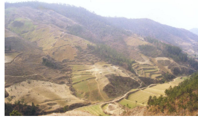
图 1 高边坡地形图 Fig.1 A slope surface
